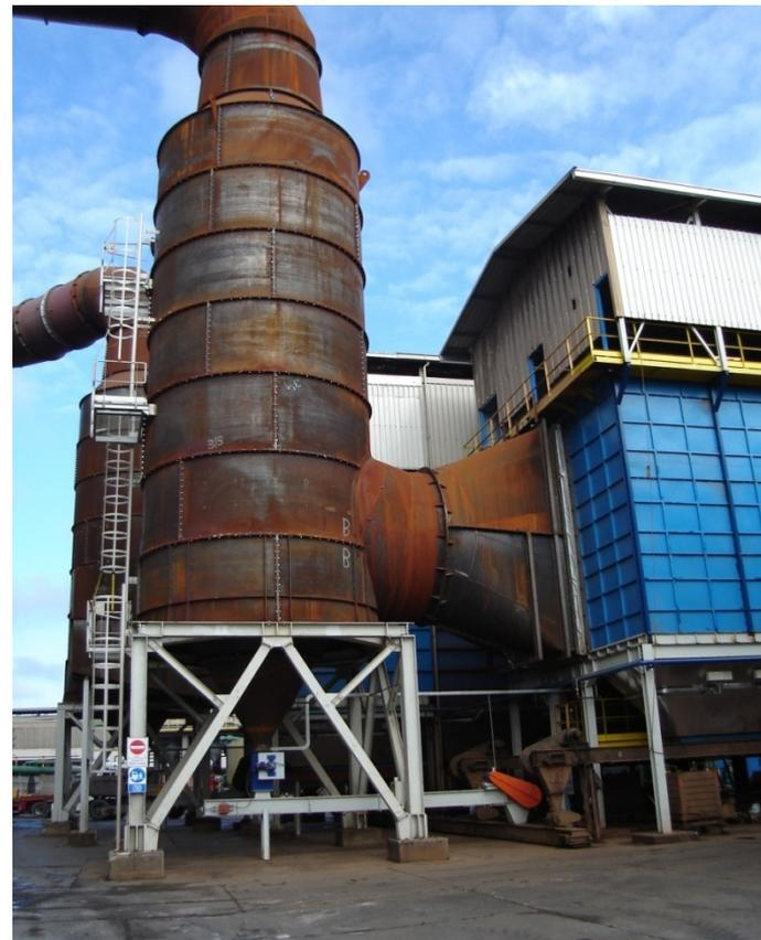
Переоборудование пыле-очистки на линии дуговой электропечи на вертикальный предварительный циклон-сепаратор
