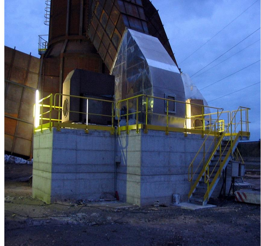
Система пыле-очистки с башней гашения, бустером, рукавными фильтрами и вытяжками
