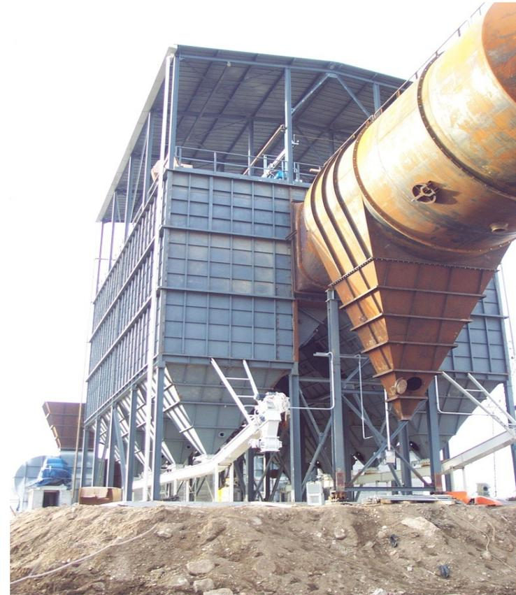
Рукавный фильтр системы «pulse jet», камера испарительного охлаждения, вытяжки, аксиальный циклон
