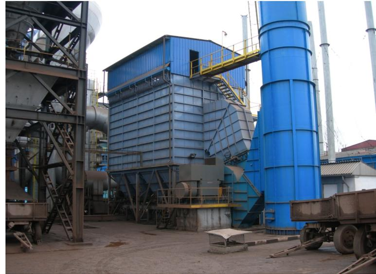
Система фильтрация от пыли на первичной линии дуговой электропечи и печь-ковша + охлаждение + природный теплообменник + горизонтальный циклон
