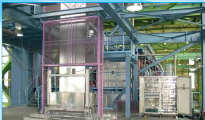
Установка охлаждающей секции
